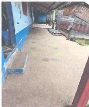
Foto 3: Mantenimiento de corredor y losa de patio
