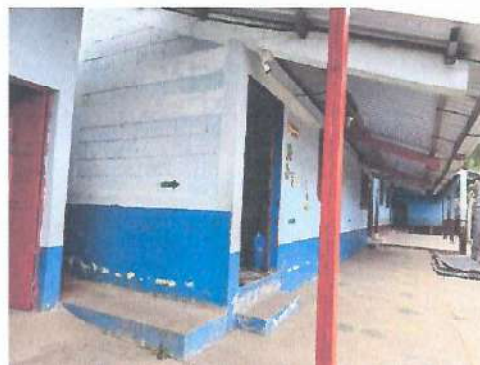
Foto 4: Mantenimiento de corredor y losa de patio
