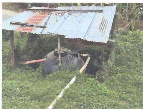
Foto 5: Mantenimiento y reparación de cerco y cubierta de lamina de fosa septica
