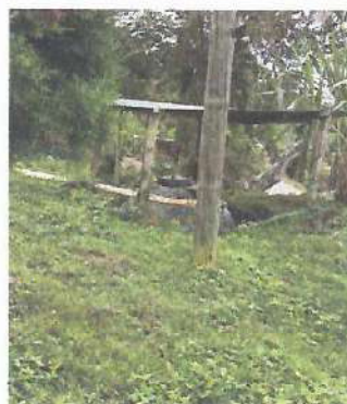
Foto 6: Mantenimiento y reparación de cerco y cubierta de lamina de fosa septica
