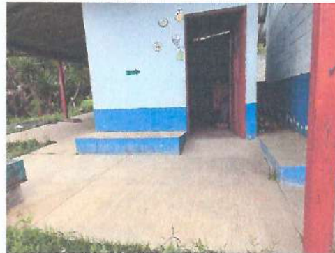
Foto 2: Mantenimiento y a de cocina
